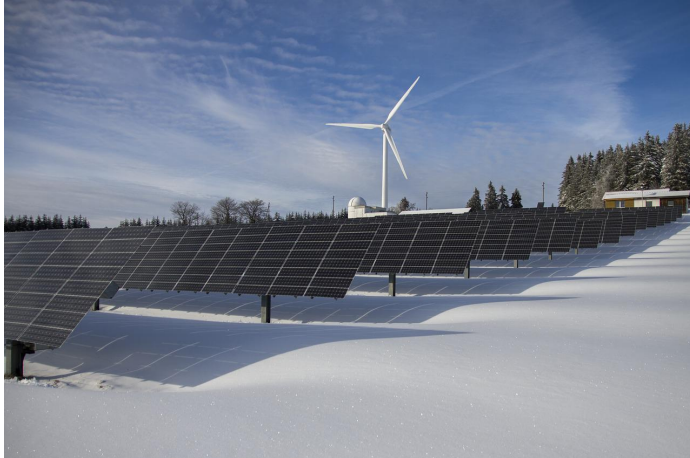
Figuur 66 De zon voorziet ons de komende 10 miljard jaar van een continue aanvoer van grote hoeveelheden energie. We kunnen die rechtstreeks oogsten via fotovoltaïsche zonnepanelen en windturbines. Daarnaast zorgt de zon ook voor de nodige energie voor fotosynthese waardoor we kunnen stellen dat de klassieke brandstoffen uiteindelijk van de zon afkomstig zijn.
