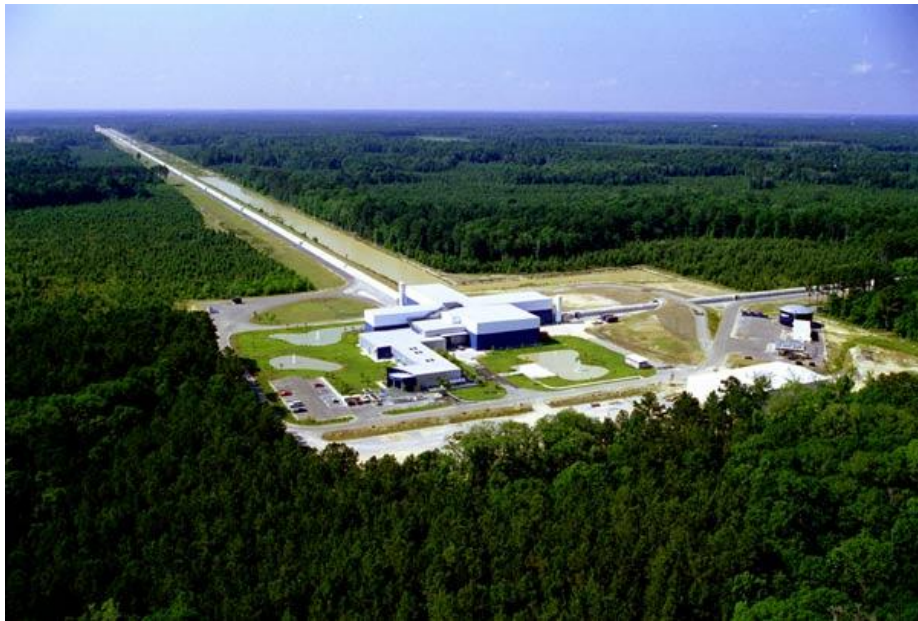
Figuur 3.20: De LIGO detector in Amerika. Deze bestaat uit twee tunnels van 4 km lang waar lichtstralen doorheen gestuurd worden. Door zwaartekrachtsgolven veroorzaakt door het instorten van zwarte gaten in het heelal voorspelt Einstein een lengteverandering van de buizen van 10^{-18} m. Dit is waarneembaar met zeer nauwkeurige meetapparatuur. Tot nog toe zijn er geen zwaartekrachtsgolven waargenomen.
