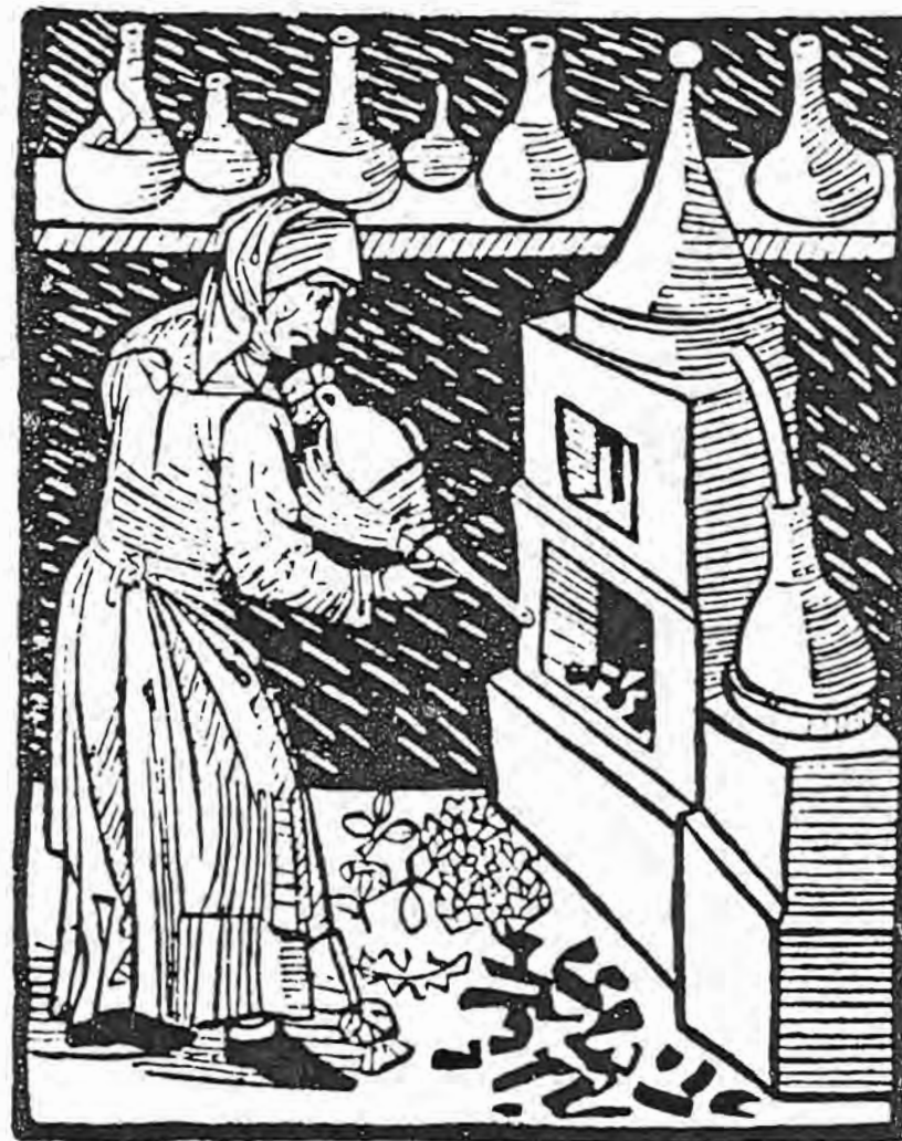
Afbeelding 8. Rozenhoed (Michael Puff von Schrick, circa 1478). Om de koeling bij destillatie te verbeteren (men hield de ontvanger koel in een vat met koud water, terwijl de helm door de omgevende lucht werd 'afgekoeld'), ontwikkelde zich een kegelvormige helm, de rozenhoed.
