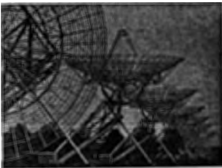
De radiotelescoop van Westerbork bestond tot 1969 uit één spiegel met een diameter van 25 m. Sindsdien zijn er elf bijgebouwd, die op een 1,6 km lange rail zijn opgesteld, en zo als een reusachtige telescoop dienst doen.
