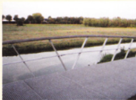
De reling van de brug
