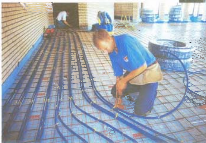
FIG. 4 De vloerverwarming wordt aangelegd: warmwaterleidingen waarop later een tegelvloer komt te liggen.
