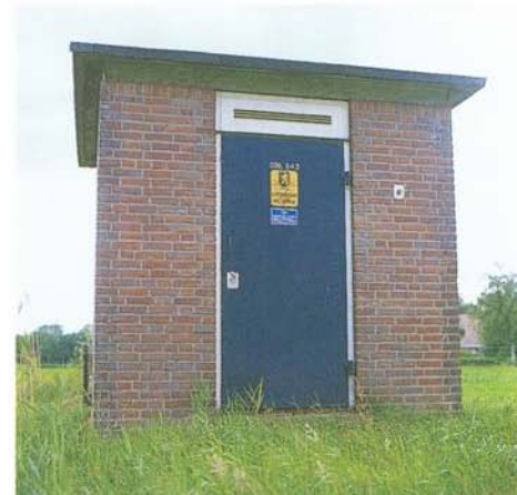
FIG. 31 Een transformatorhuisje.
