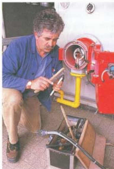
FIG. 17 Verwarmingsmonteur maakt de branders van de cv-ketel schoon.
