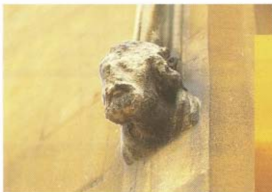
FIG. 21 Een kalksteenbeeld dat door de zure regen flink is aangetast.
