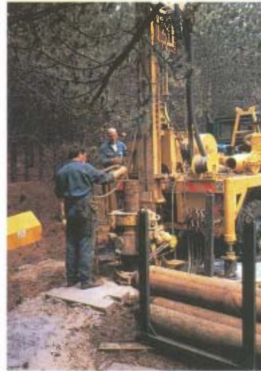
FIG. 3 Boren naar grondwater.
