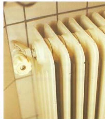
FIG. 12 Verschillende soorten radiatoren: paneelradiator (a), dubbele paneelradiator met lamellen (b), ledenradiator (c).
