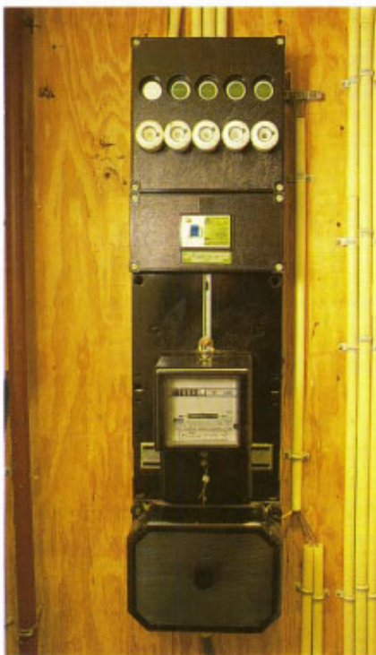
FIG. 6 De meterkast.
