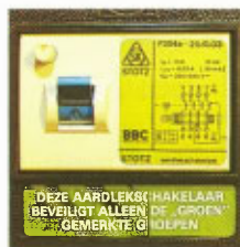
FIG. 14 Een aardlekschakelaar.
