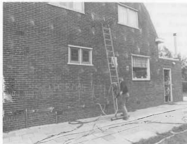
fig. 44 Het aanbrengen van glaswol tijdens de bouw.
