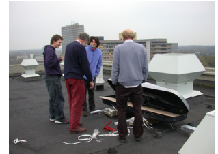
Bevestigen van de skibox aan twee los op het dak liggende betonnen balken.
